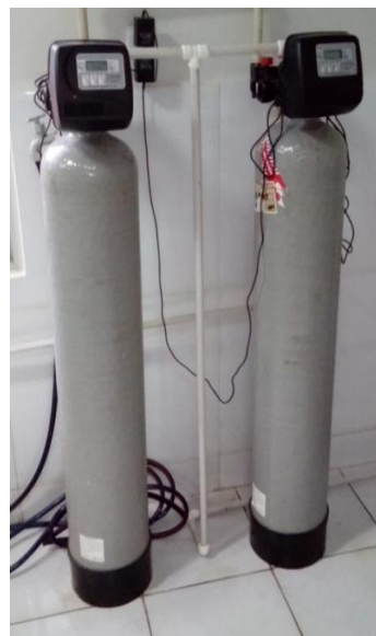
Foto 12: Filtros de arena y carbón para la potabilización de agua
